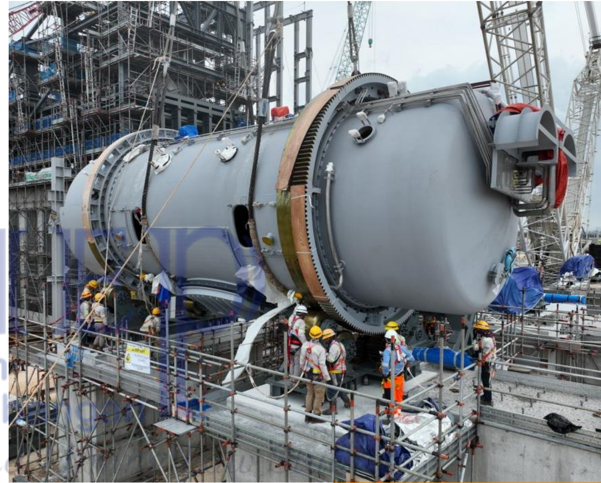
Pemasangan Anode Furnace
